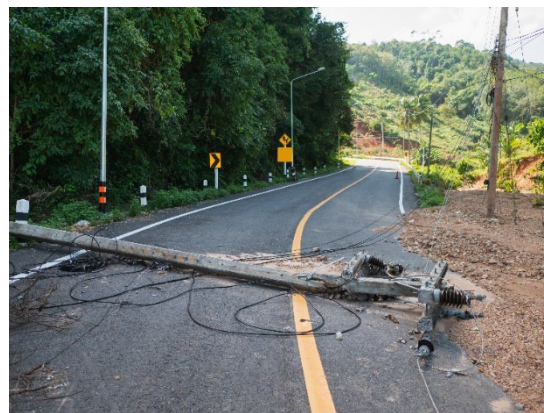
Abbildung 13: Durch Sturm und heftigen Niederschlag beschädigter Strommasten (Chaitoep, o. J.)
